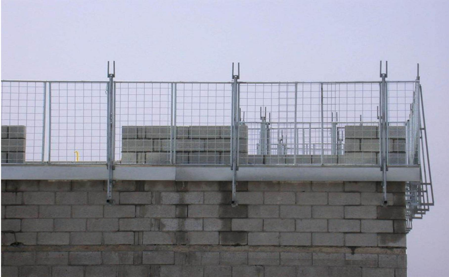
*Sistema de calha para captação de resíduos em geral decorrentes da elevação da alvenaria*
